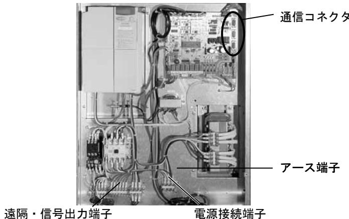
1. 電源コード容量は下表の最大運転電流を参考し選定してください。アース線の接続は、配電盤内のアース用ビスを用いてください。また、電源および信号端子台は、下表のネジ径、端子台幅を参照してください。
